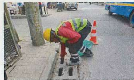
Limpieza y mantenimiento de sumideros. Fecha: 08-03-2024.
