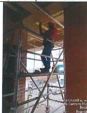
INSTALACION DE TUBERIA EMT NIVEL 8,00 BLOQUE 2 - 21/03/2024
