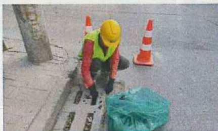
Limpieza y mantenimiento de sumideros. Fecha: 08-03-2024.
