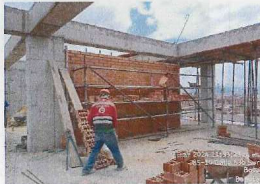
MAMPOSTERIA EN LADRILLO FACHADA NIVEL 0,00 BLOQUE 7 - 09/03/2024
