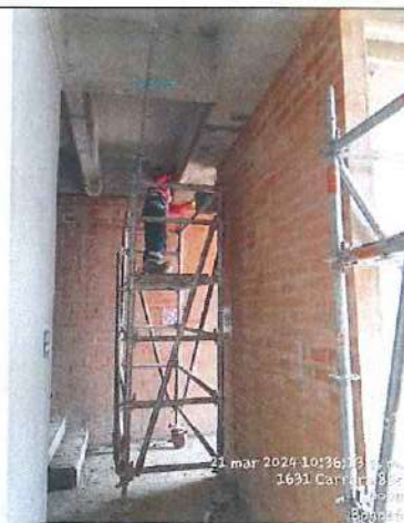
RESANE DE TORTA INFERIOR NIVEL 4,20 BLOQUE 2 - 21/03/2024
